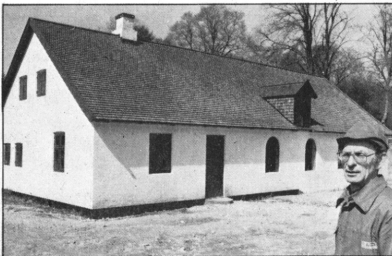
Bygningen ser ud nøjagtigt som den gjorde i Rebstrup. Men murværk, tag og vinduer er nyt – de gamle materialer var for ringe.
